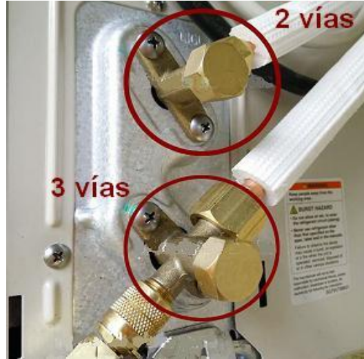
Válvulas de servicio - 2 y 3 vías
